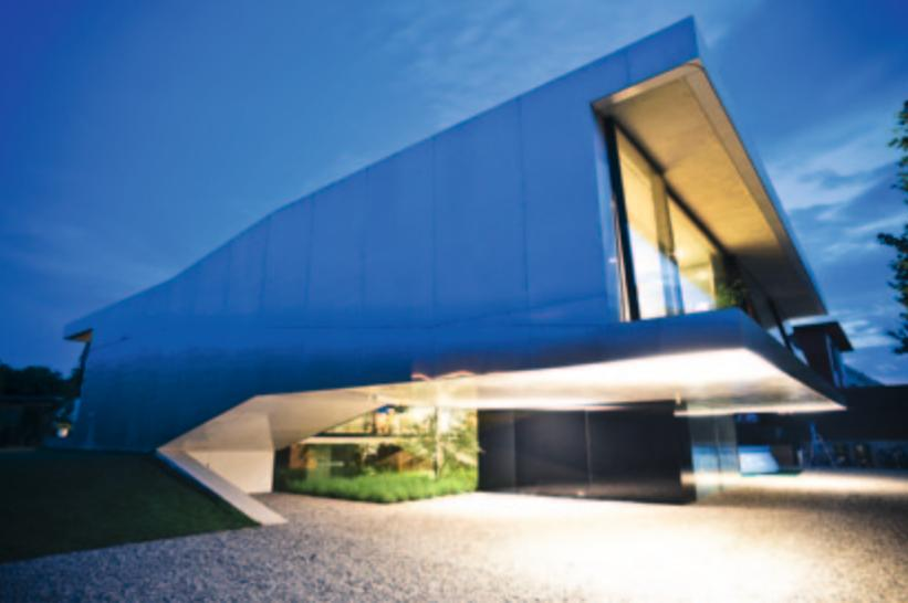
Wie ein **Brückenglied** streckt sich das Gebäude in die Luft, gestützt lediglich auf einen Betonkern im Entree. Die Seitenansicht lässt von der Freiheit und Großzügigkeit im Inneren kaum etwas ahnen.
